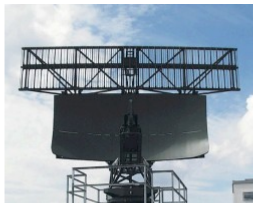
Abb. 2: Primärradarantenne (Parabolreflektor) mit aufgestockter Sekundärradarantenne (LVA-Antenne: hier die obere breitere Gitterkonstruktion)
